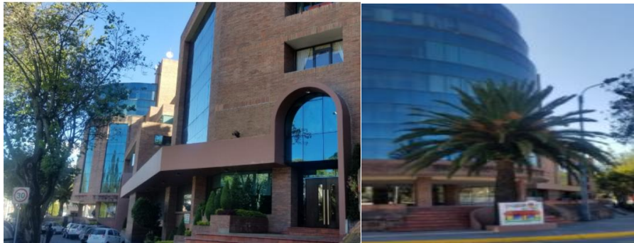
Figura 8: Edificio Paseo del Puente (Cuenca)
