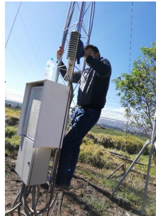
Figura 9: Limpieza de sensor de temperatura y humedad ambiental
